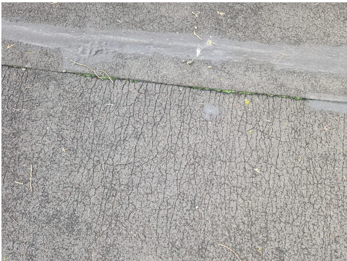
Zdjęcie 7 Zużyte pokrycie dachowe z papy termozgrzewalnej poprzez naturalne starzenie się
