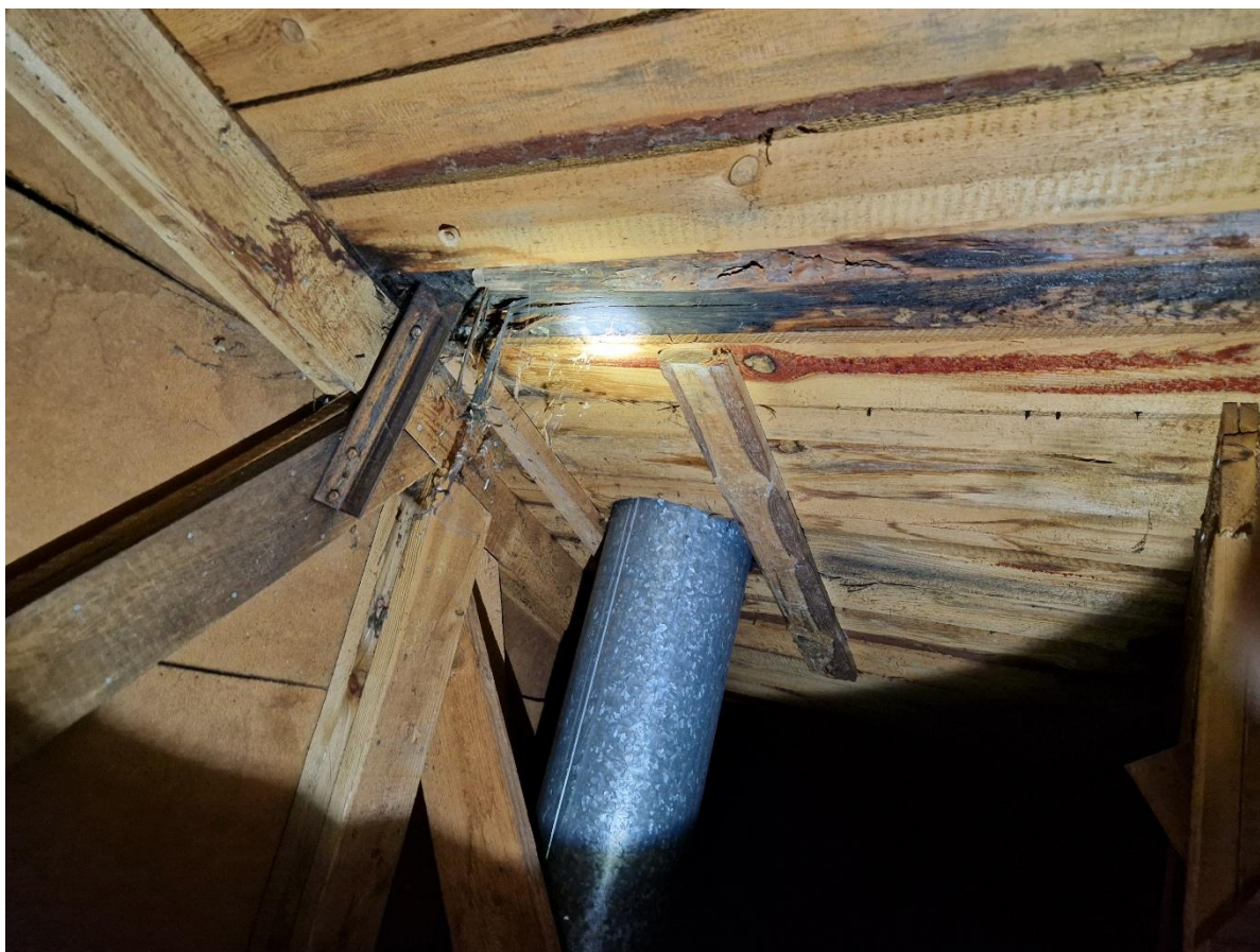
Zdjęcie 19 Przebicie kątownika oraz przejście wentylacji przez przekrycie – zawilgocone deskowanie w rejonie kształtownika
