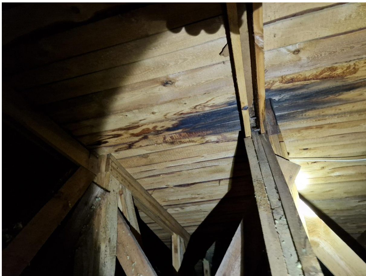
Zdjęcie 18 Przebicie przekrycia poprzez kątownik i zawilgocenie deskowania
