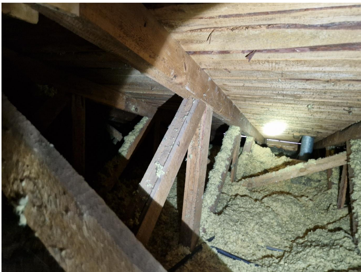
Zdjęcie 16 Widok przejść wentylacji przez przekrycie dachu w części frontowej
