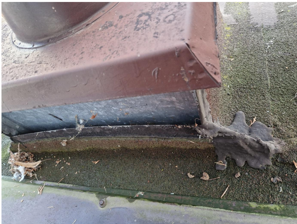
Zdjęcie 9 Nieszczelności przy podstawie wentylatora
