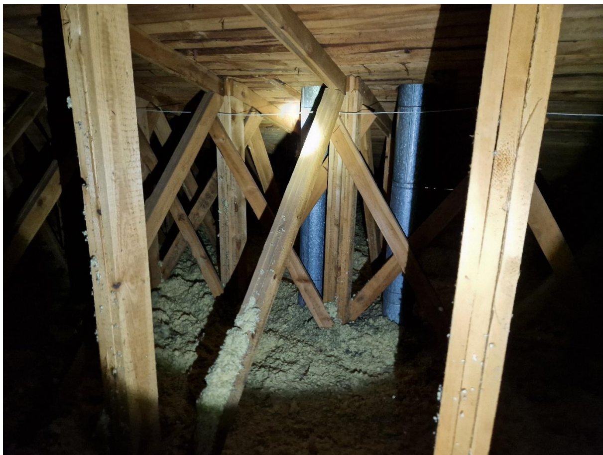
Zdjęcie 17 Widok przejść wentylacji przez przekrycie dachu w części D
