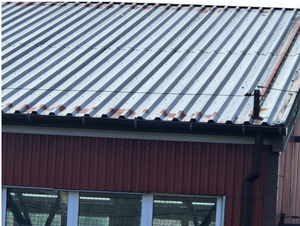
Zdjęcie 10 Korozja pokrycia z blachy trapezowej w liniach instalacji odgromowej
